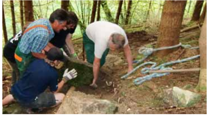
Wegebau ist Schwerstarbeit – unter Regie von Egon Ganahl werden alte Wegebausteine wieder eingebaut
