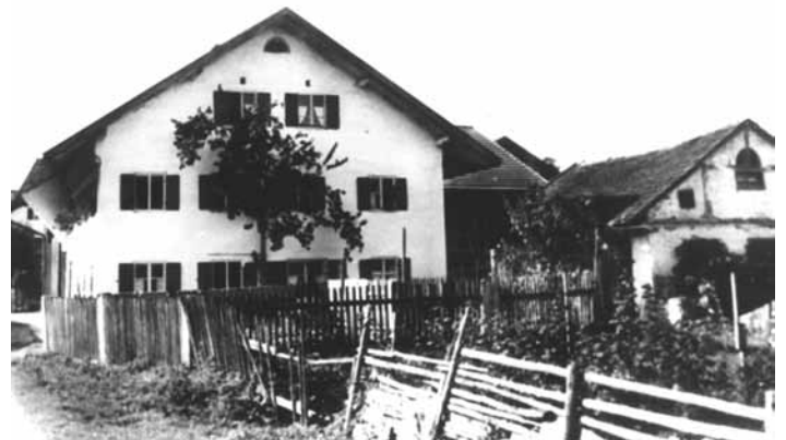
Das Humm-Haus mit der ehemaligen Schmiede (rechts)
