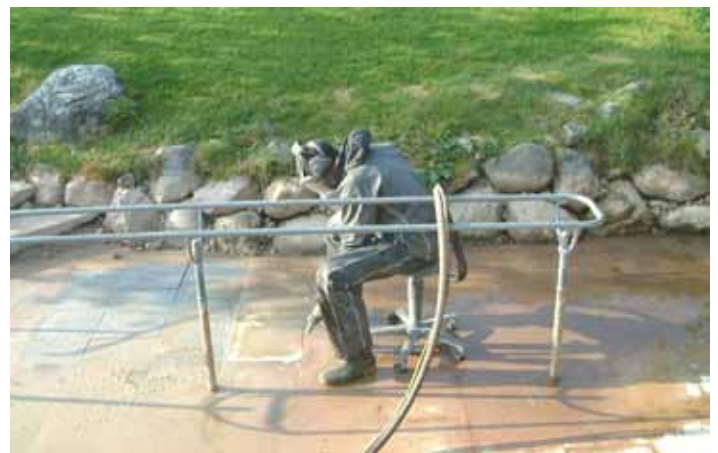
Nikolaus Schweiger (icyclean) beim Sandstrahlen und das frisch sanierte Becken
