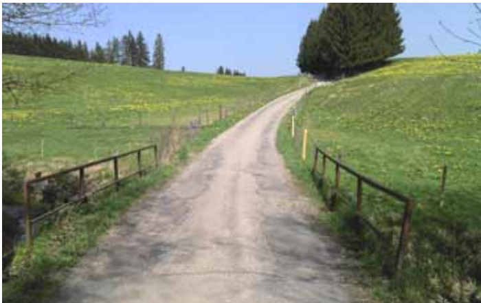
Brücken bei der Huttlermühle und nördlich Sameister
